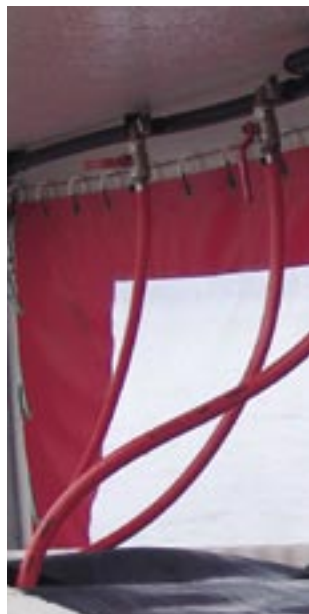
Under: Monterte kraner gjør at man kan regulere vannmengde og hvilke stabler som skal vannes.
